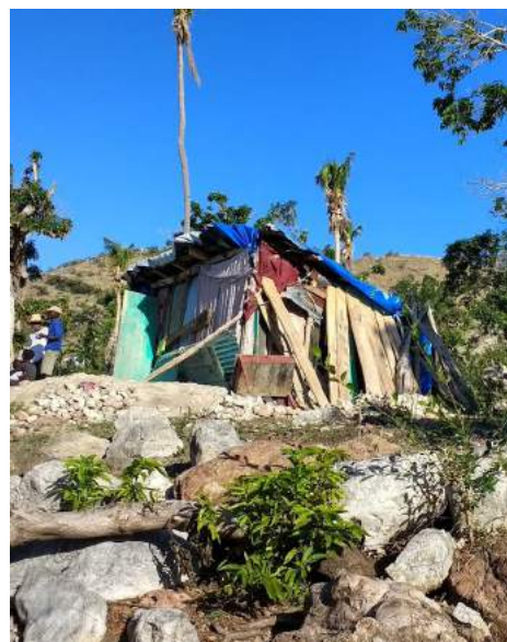
Maison détruite à Digo, Côteaux, février 2017
