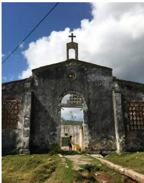
Chapelle détruite utilisée comme abri, Chambellan, janvier 2017
